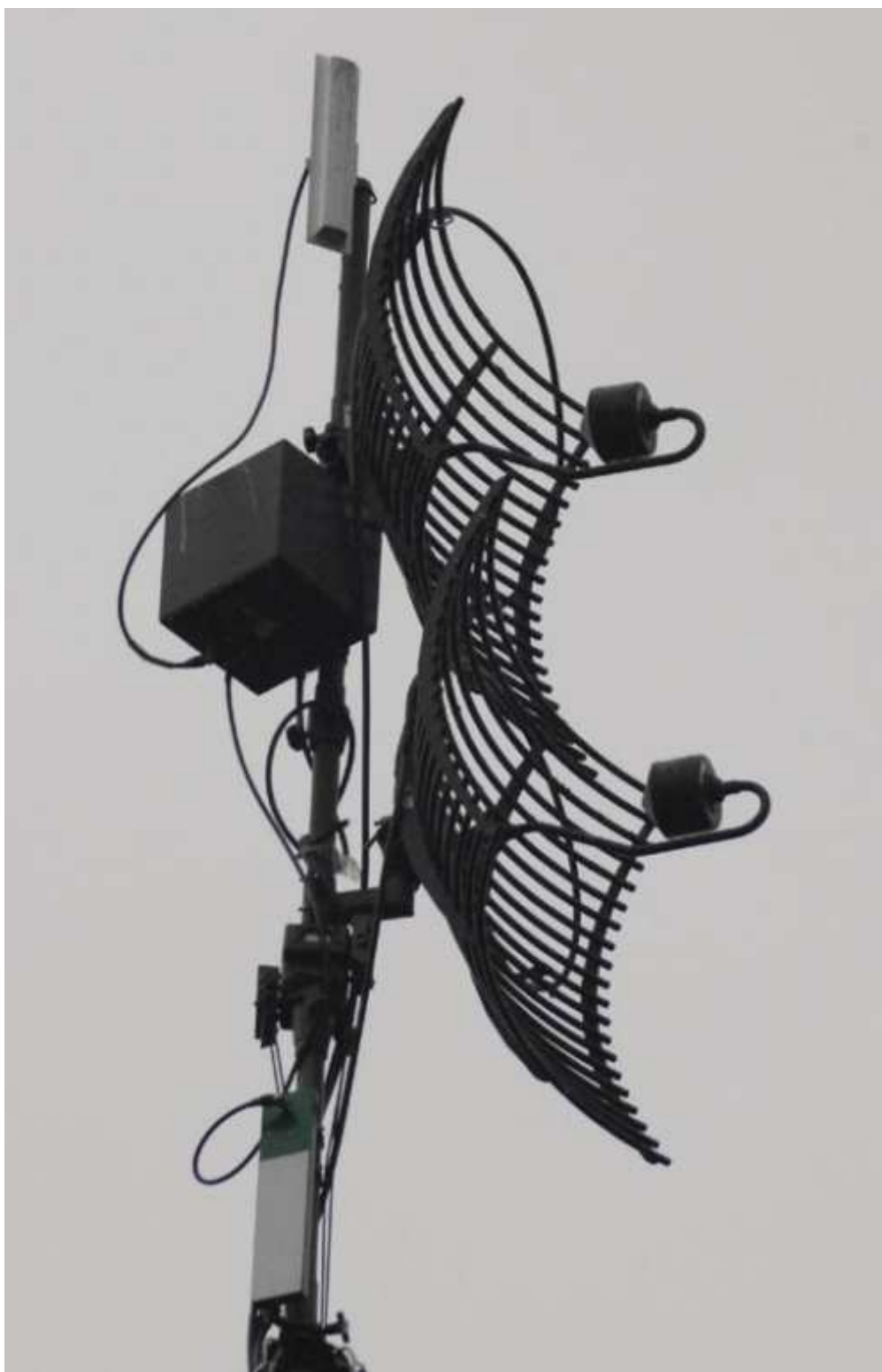
Anteny radiolinii Transbit R-450A i systemu dostępowego
